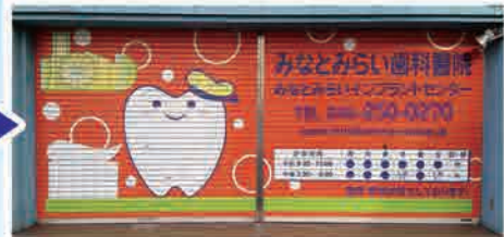
シャッターラッピング施工
